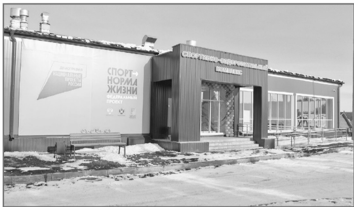
Физкультурно-оздоровительный комплекс в поселке Плишкино (Хомутовское МО, Иркутский район) возведен по федеральному проекту «Спорт – норма жизни». На его строительство из бюджетов разных уровней было потрачено 78 миллионов рублей.
