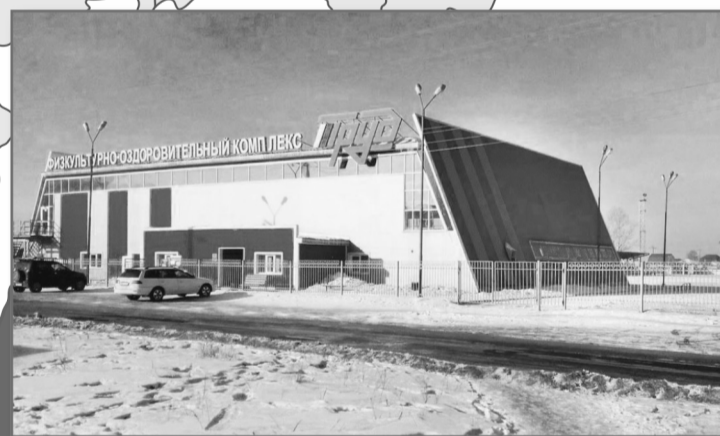
Завершилась реконструкция физкультурно-оздоровительного комплекса «Труд» в Нижнеудинске. В составе комплекса – стадион, трибуны, беговая дорожка, легкоатлетический манеж. Общее финансирование объекта составило 314,5 млн рублей.
