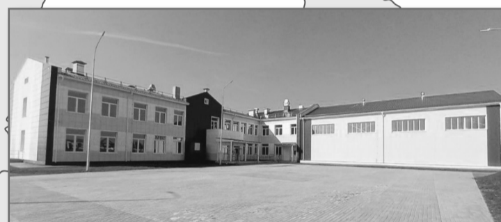
В селе Бажир Заларинского района открыли новое здание основной общеобразовательной школы на 154 ученика. Объект возведен по программе «Комплексное развитие сельских территорий». Новая школа состоит из двух учебных корпусов с 15 учебными кабинетами, блока для столовой и актового зала, одноэтажного спортзала и отдельного блока для групп продленного дня.
