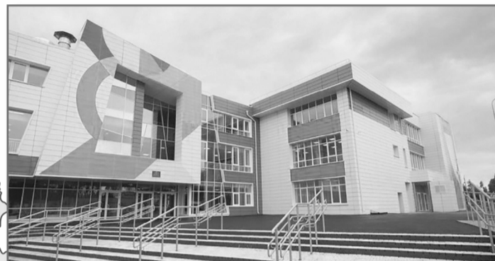
В Тулуне, в микрорайоне Березовая Роща, построили новую школу на 1275 мест. В новое здание переехала средняя общеобразовательная школа № 2 имени Героя Советского Союза Н. Е. Сигаева. Летом 2019 года она серьезно пострадала от паводка. Было принято решение строить новое здание в микрорайоне Березовая Роща, куда переселяли людей, потерявших из-за наводнения жилье.
