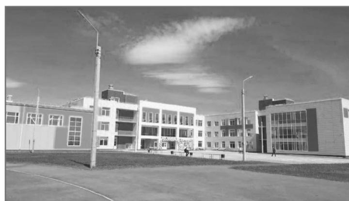
Самая большая школа в Усть-Ордынском Бурятском округе открылась в селе Баяндай. Прежнее здание было признано аварийным. Строительство нового корпуса на 725 мест проходило за счет государственной программы Иркутской области «Развитие образования» на 2019–2024 годы. Стоимость работ составила 907,1 млн руб.
